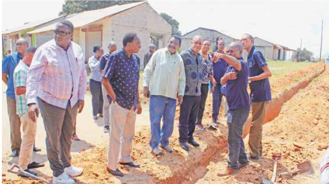
Mwenyekiti wa Bodi ya DAWASA Jenerali Mstaafu Davis Mwamunyanje akiwa na baadhi ya Wajumbe wa Bodi walipotembelea mradi wa Maji katika Mji wa Mkuranga unaosimamiwa na DAWASA na kuona shughuli za ulazaji wa mabomba na ujenzi wa tanki la Maji lenye ujazo wa lita Milioni 1.5.
