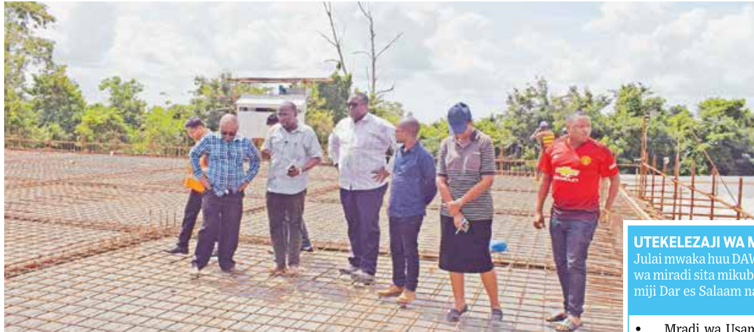
Katibu Mkuu wa Wizara ya Maji Prof. Kitila Mkumbo akikagua ujenzi wa tenki la maji lenye ujazo wa lita milioni 6 litakalohudumia Wilaya ya Kisarawe pamoja na maeneo Pugu, Chanika, Majohe na Gongo la Mboti.
